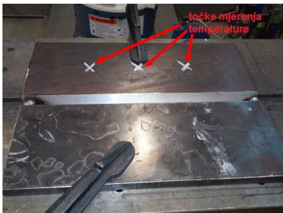
Slika 35. Spoj 1 pripremljen za zavarivanje
