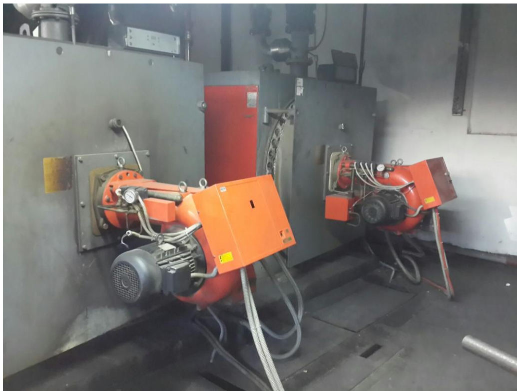
Slika 18. Prikaz zatvorenih kotlova u kotlovskom postrojenju
