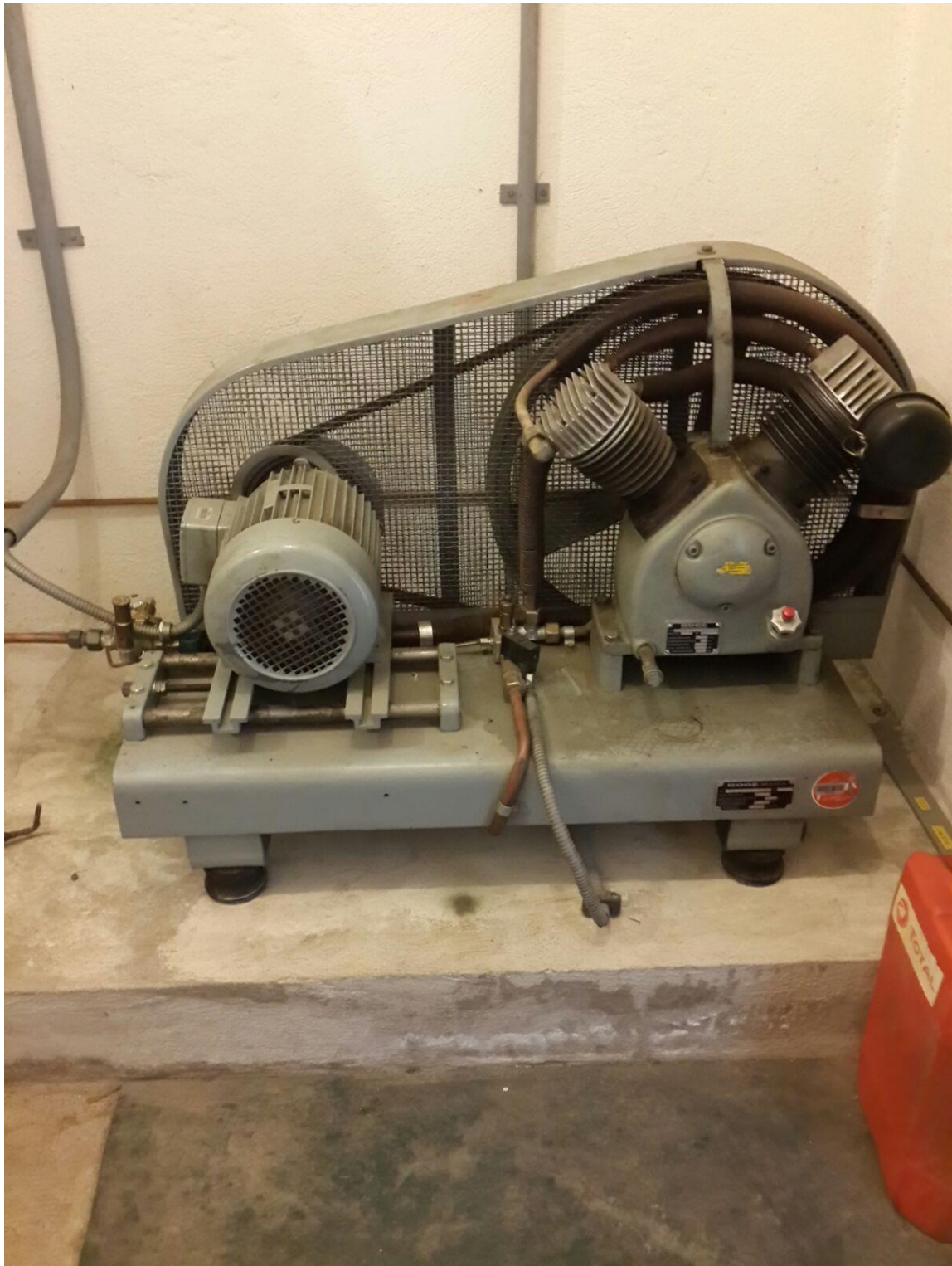
Slika 22. Kompresor za niskokomprimirani medicinski zrak (5 bar)
