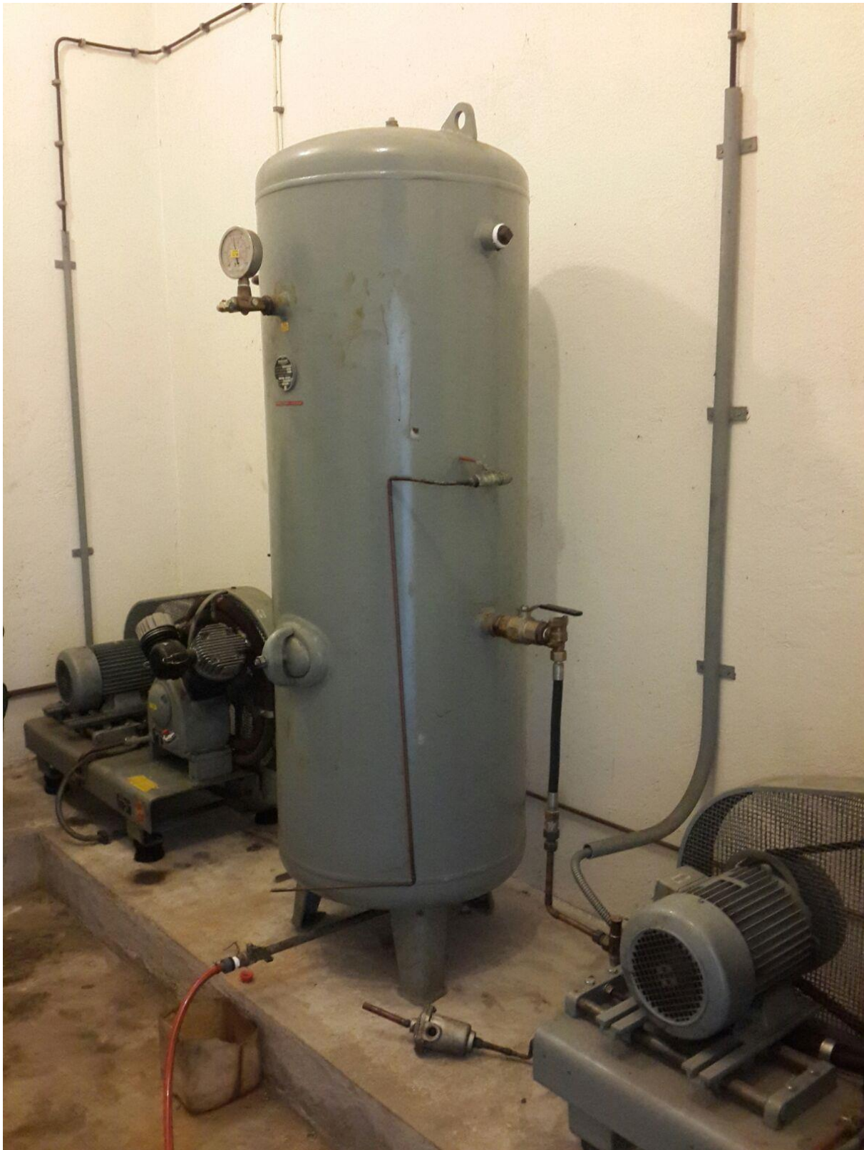
Slika 23. Spremnik za komprimirani zrak
