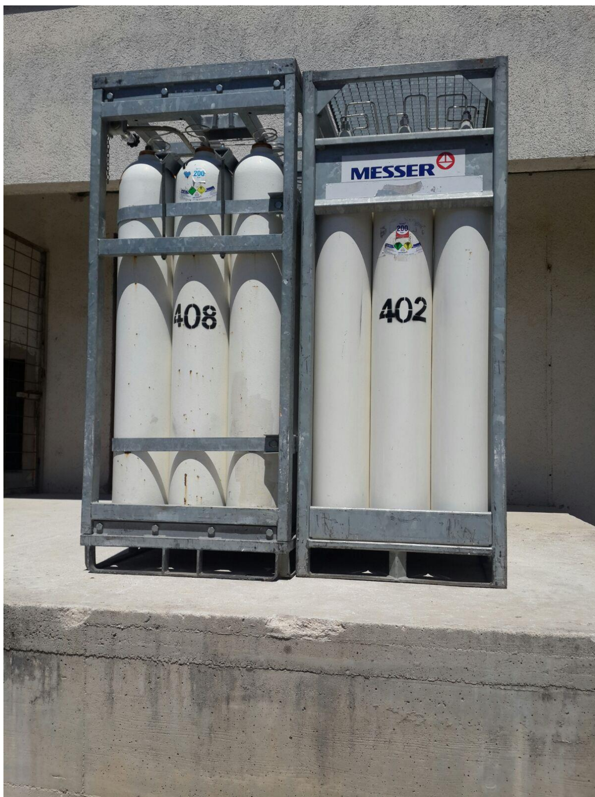
Slika 26. Spremište baterija dušičnog oksidula
