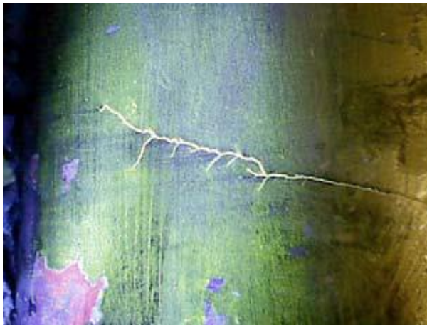
Slika 25: Indikacija pukotine prikazana fluorescentnim penetrantom [20]
