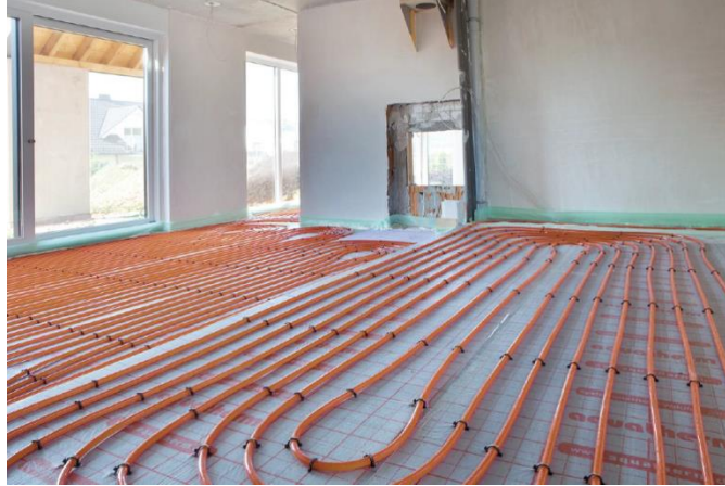
Slika 1.11. Podne cijevne petlje
