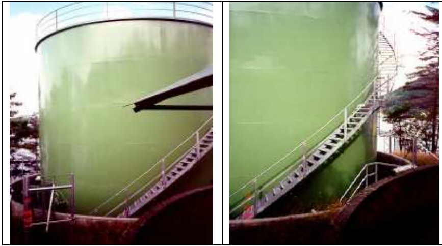
Slika 33. Spremnik za naftu zaštićen hibridnim premaznim sistemom [12]
