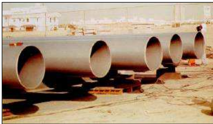
Slika 34. Cjevovod za plin zaštićen hibridnim premaznim sistemom [12]
