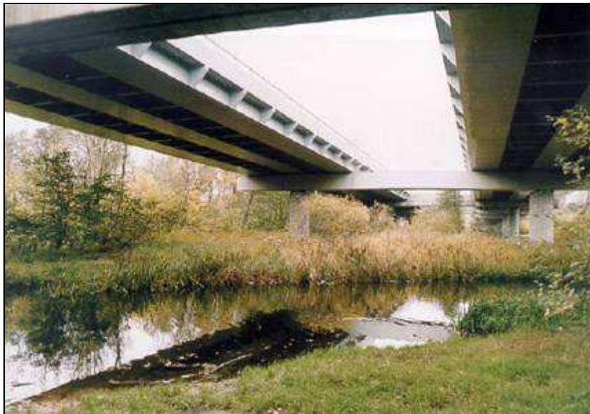
Slika 31. Dijelovi mosta zaštićeni vodorazrijedivim premaznim sistemom [14]
