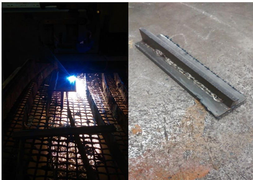
Slika 29. Rezanje viška dijelova ploča kutnog spoja
