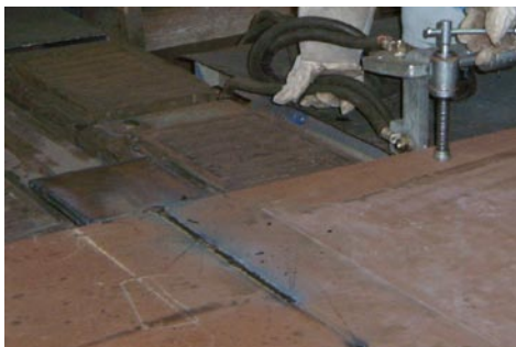
Slika 3.3.3 Priprema za zavarivanje lima
