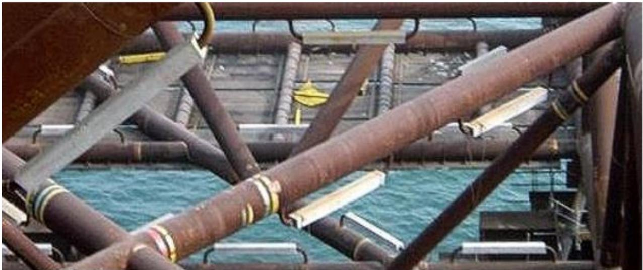
Slika 12. Prikaz katodne zaštite žrtvovanom anodom [15]
