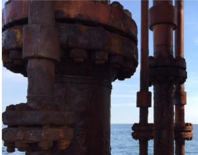
Slika 3. Primjer opće ravnomjerne korozije na platformi Ida C [2]
