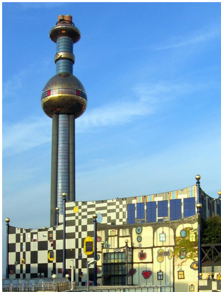
Slika 3.1. Spalionica otpada Spittelau (Beč, Austrija)[5]
