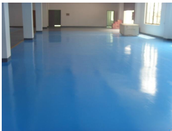
Slika 16. Epoksidne prevlake industrijskih podova [19]
