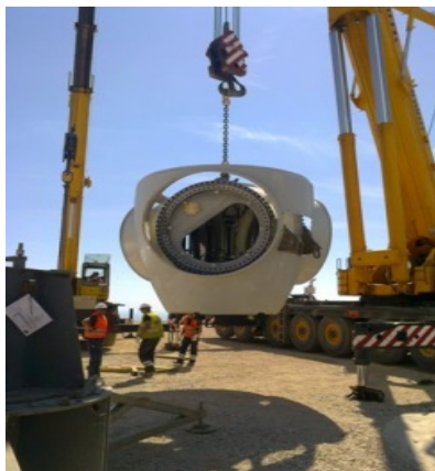
Slika 3.2 Gondola vjetroagregata [5]
