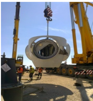
Slika 3.2 Gondola vjetroagregata [5]
