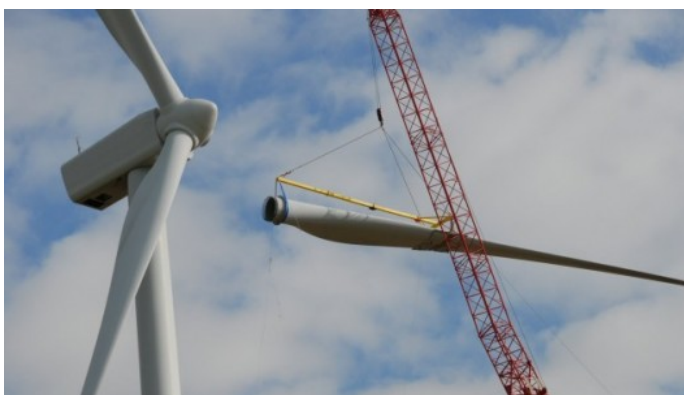
Slika 3.1 Lopatice vjetroturbine prilikom montaže [4]
