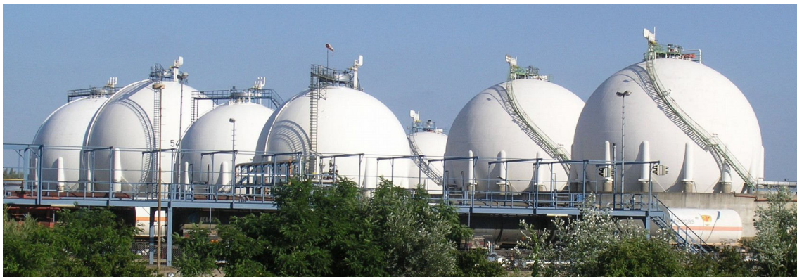
Slika 14 – Kuglasti tlačni spremnik za plinove
