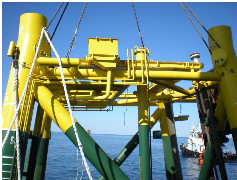
Slika 23. Podizni izdanci na platformi Izabela [15]
