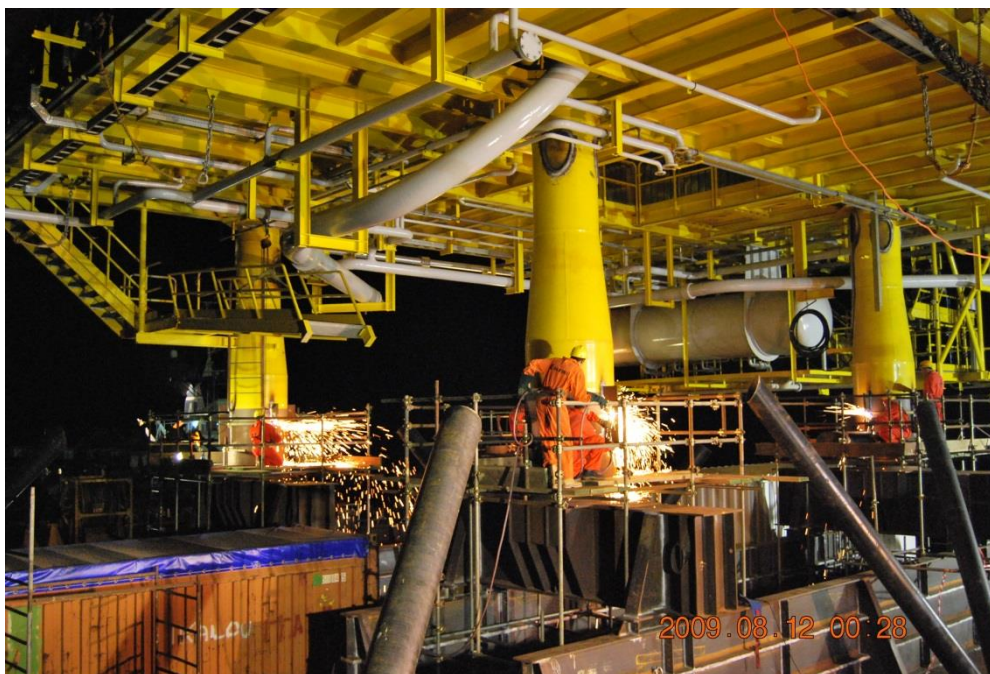
Slika 33. Uklanjanje morskog veza nadgrađa [15]
