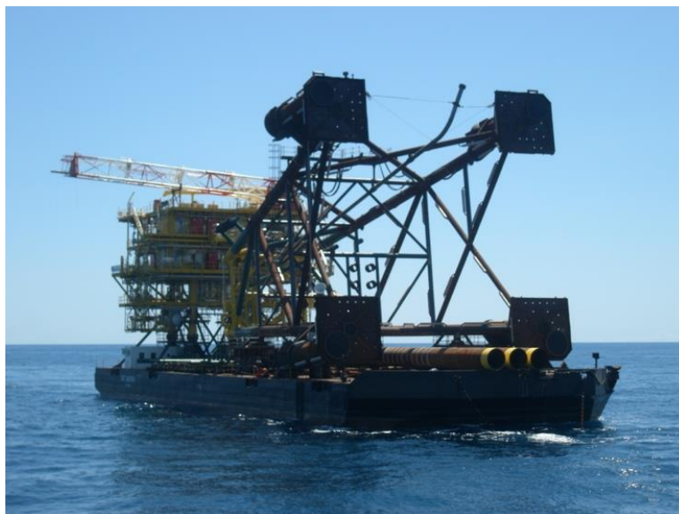
Slika 34. Transport nadgrađa i jacketa na barži [15]
