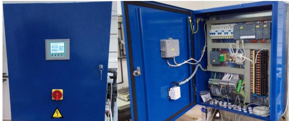
Slika 18. PLC Siemens Simatic
