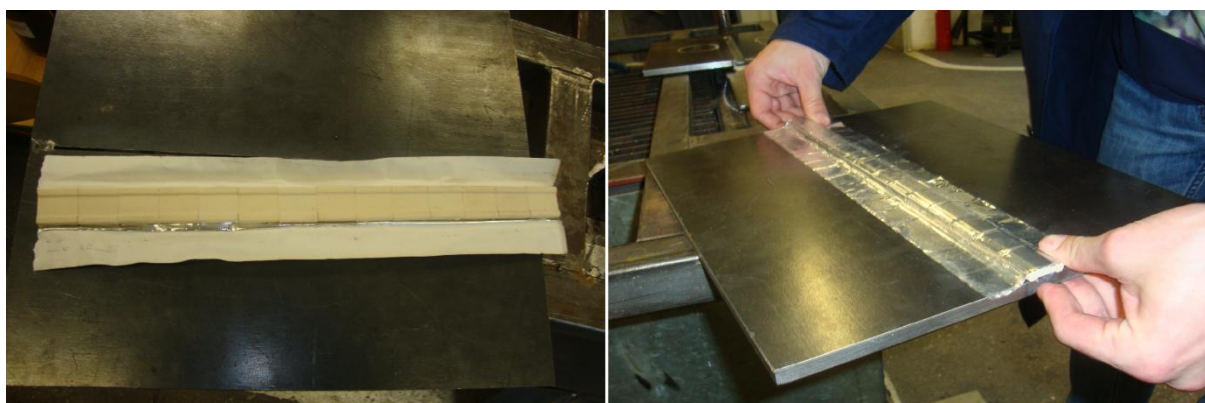
Slika 40. Stavljanje podloške za zavarivanje
