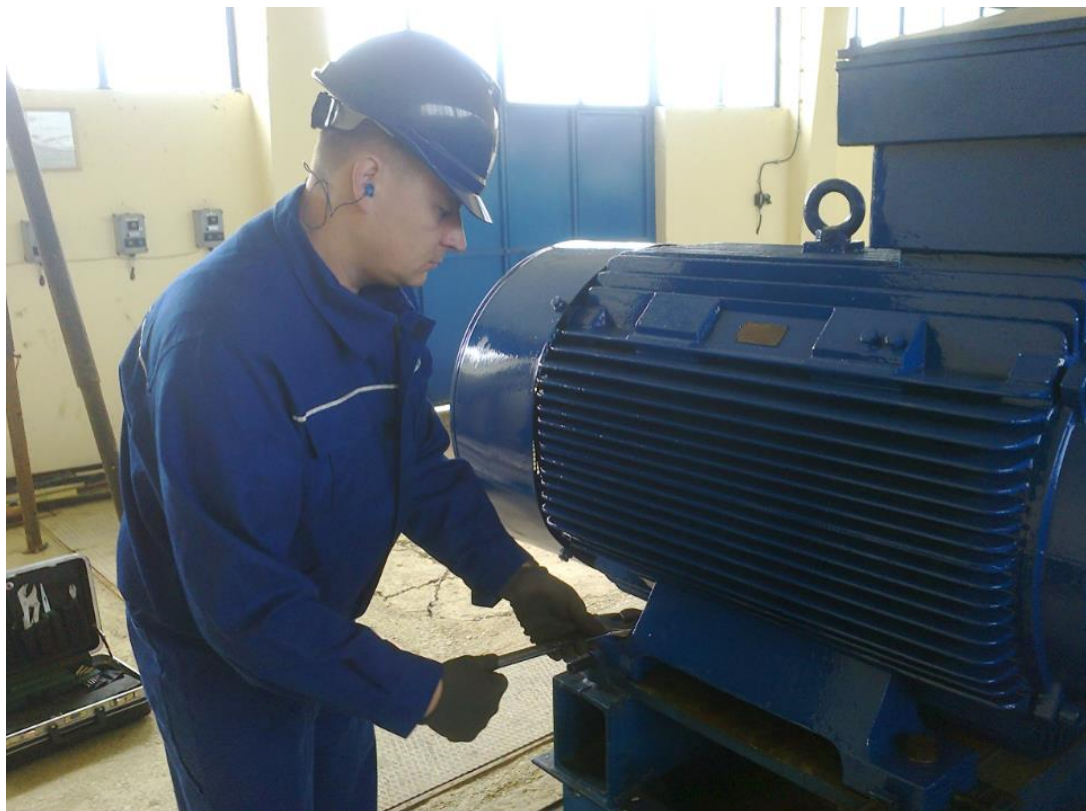
Slika 38. Stezanje temeljnih vijaka
