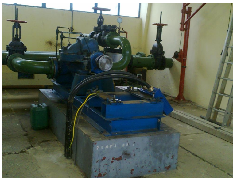
Slika 34. Prikaz postolja i pumpe prije postavljanja elektromotora
