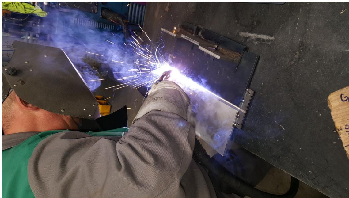
Slika 22. Zavarivanje korijena zavara sučeljenog spoja
