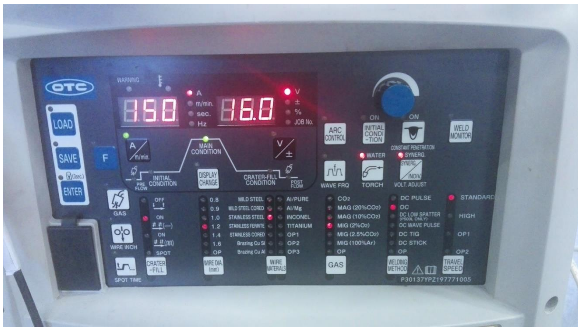
Slika 29. Parametri zavarivanja pri zavarivanju nehrđajućeg čelika
