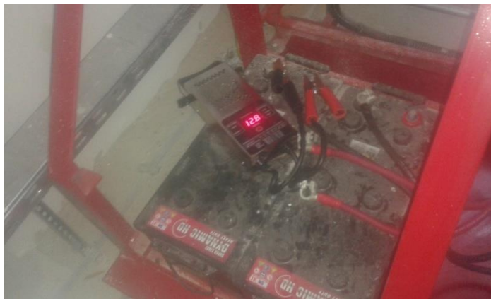
Slika 27. Ispitivanje napona akumulatora voltmetrom
