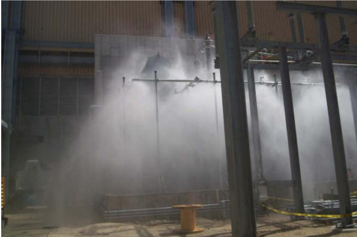
Slika 12. Prikaz aktiviranog sustava za gašenje vodenom maglom [14]
