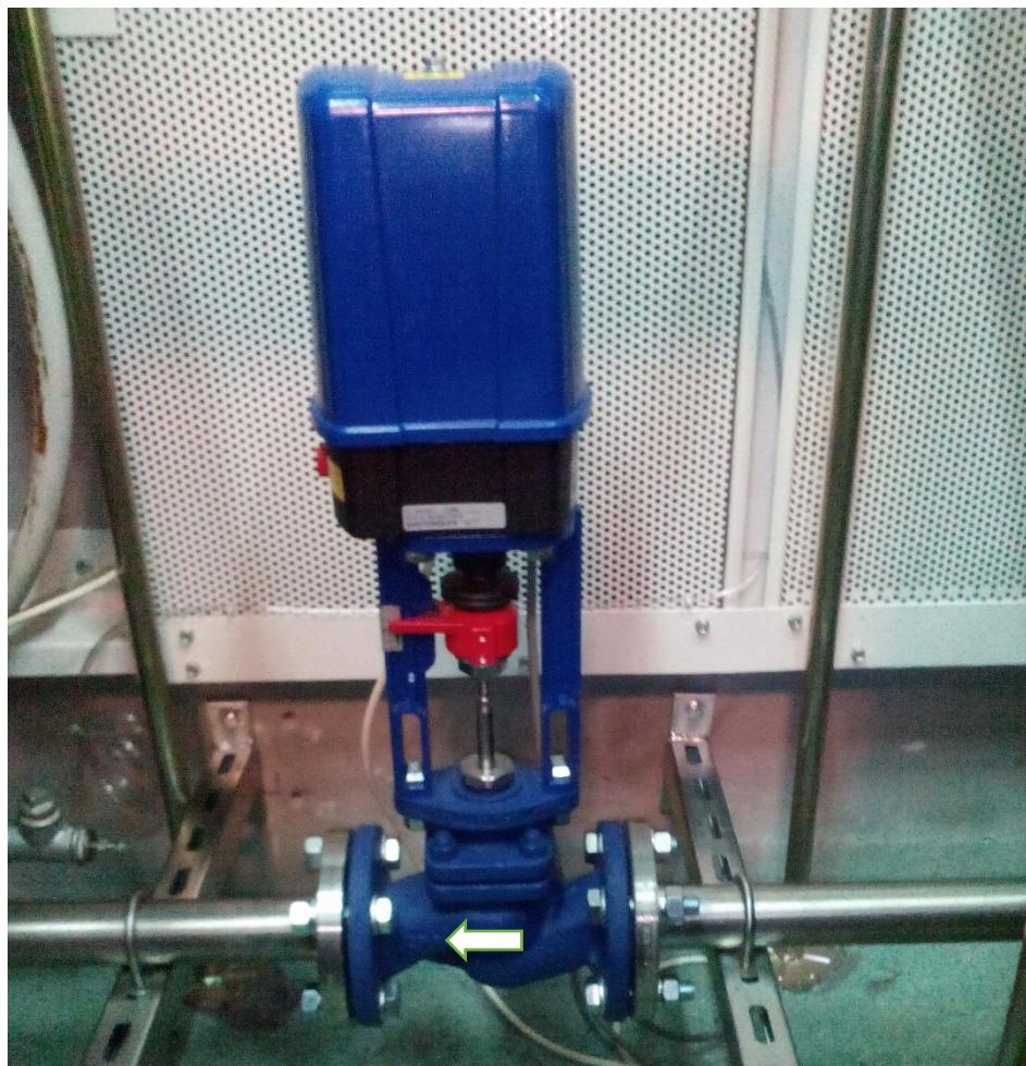
Slika 3.6. Prikaz montiranog ventila na ispušnoj cijevi.
