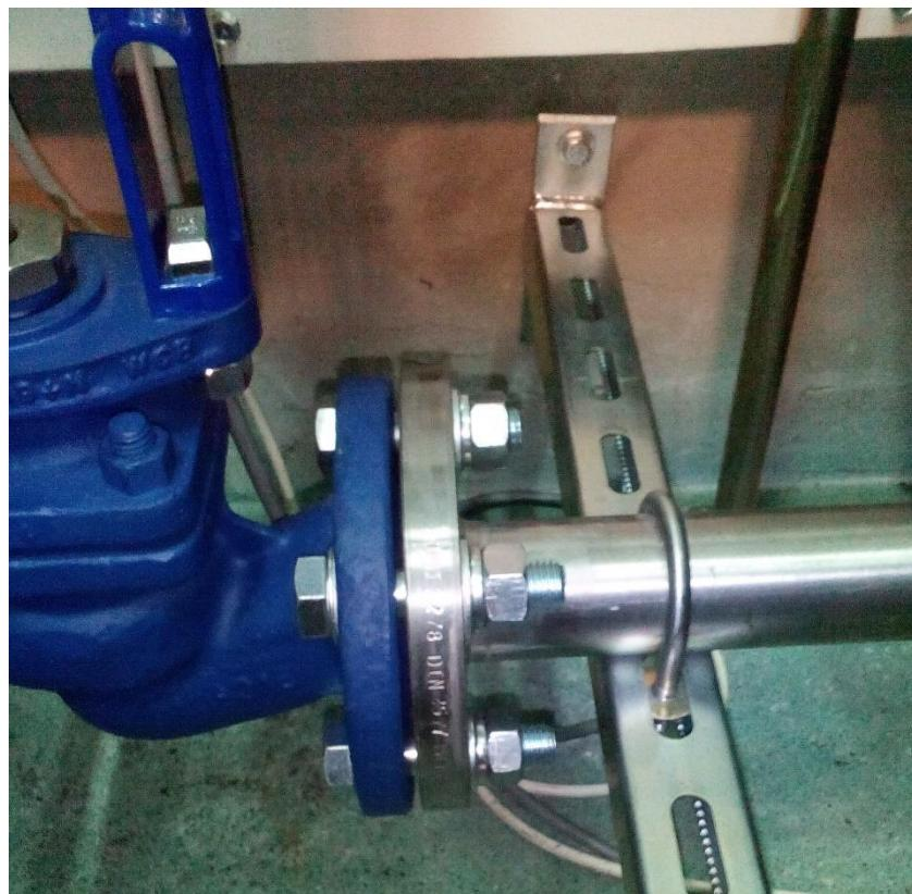
Slika 3.5. Vijčani spoj ventila i cijevi.
