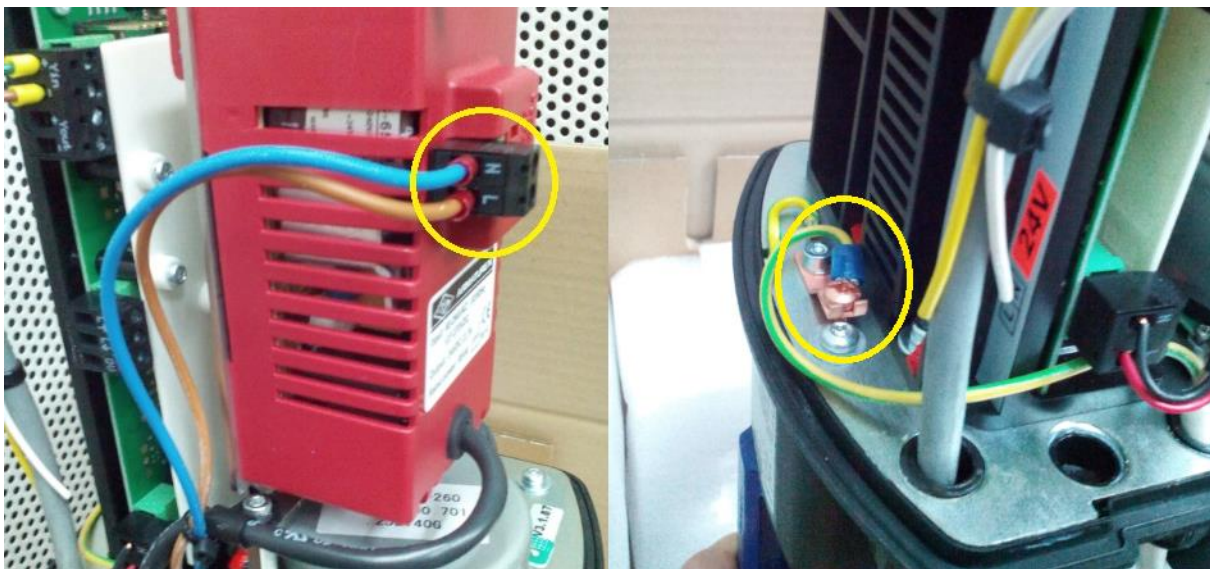
Slika 3.10. Spajanje napajanja na transformator.
