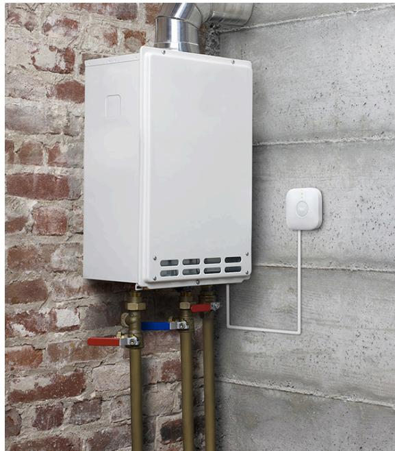
Slika 24. Nest predajnik spojen na bojler [17]
