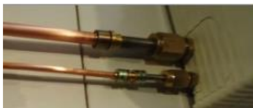
Slika 23 Spajanje cijev s „Lok-ring“ spojnica [4]
