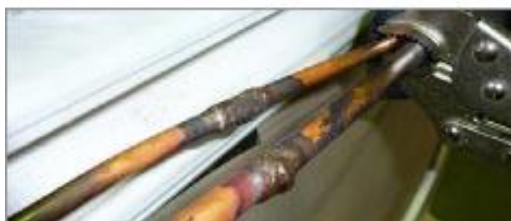
Slika 20 Mehanički spoj u zoni boravka [4]
