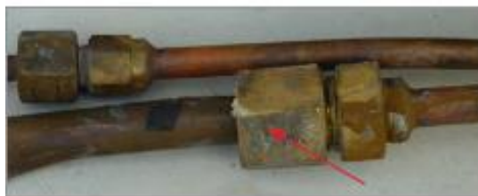
Slika 21 Uklanjanje mehaničkih spojeva cijevi lemljenjem [4]
