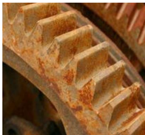
Slika 3. Opća korozija zupčanika [5]
