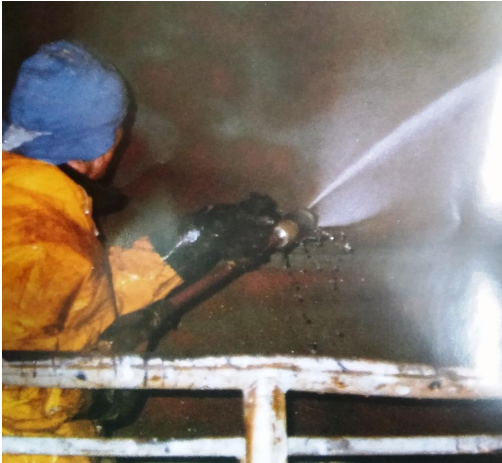
Slika 6. Ispiranje površine broda [8]
