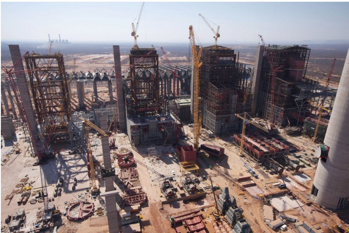
Slika 37. Generatori pare elektrane Medupi u izgradnji [7]
