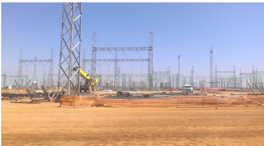
Slika 45. Dalekovod u izgradnji [6]
