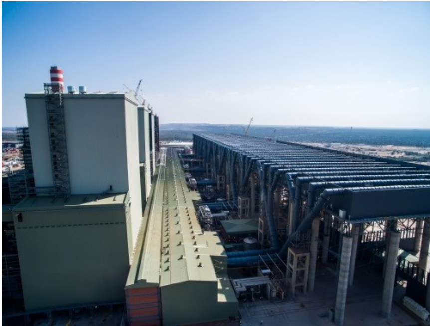
Slika 50. Spoj niskotlačnog dijela turbine i kondenzatora [6]
