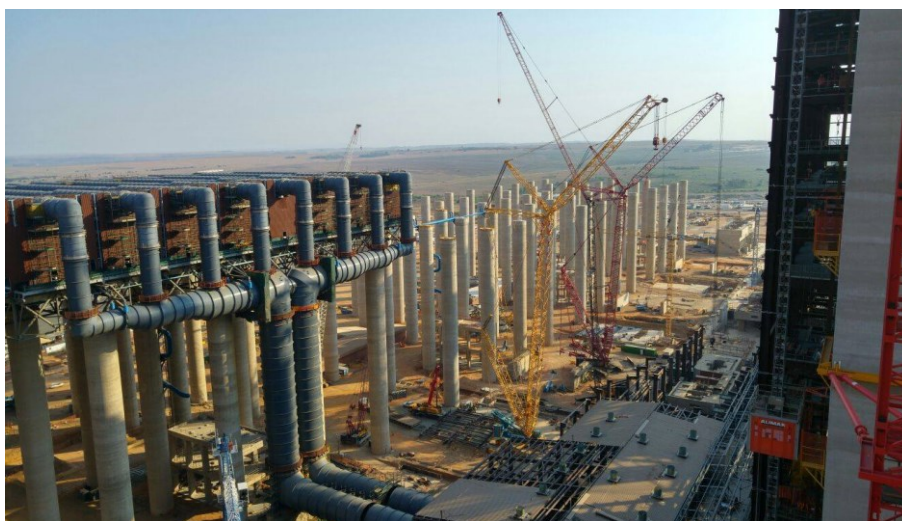
Slika 46. Nosiva konstrukcija kondenzatora
