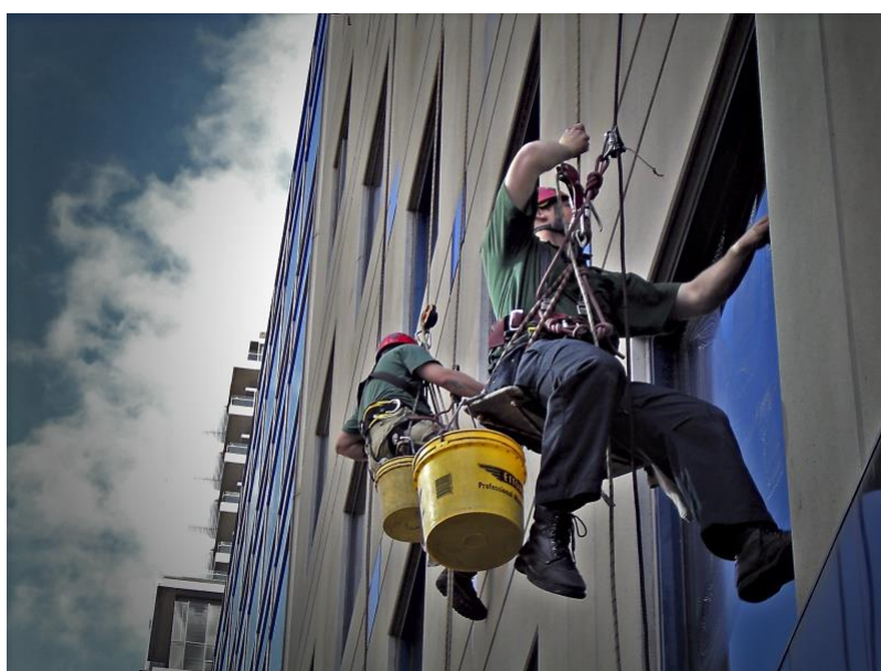
Slika 20. Ručna metoda čišćenja
