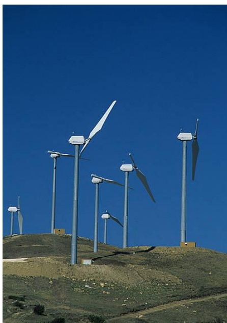
Slika 12. Rotor s jednom lopicom [11]
