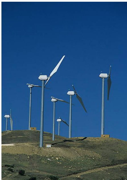
Slika 12. Rotor s jednom lopticom [11]
