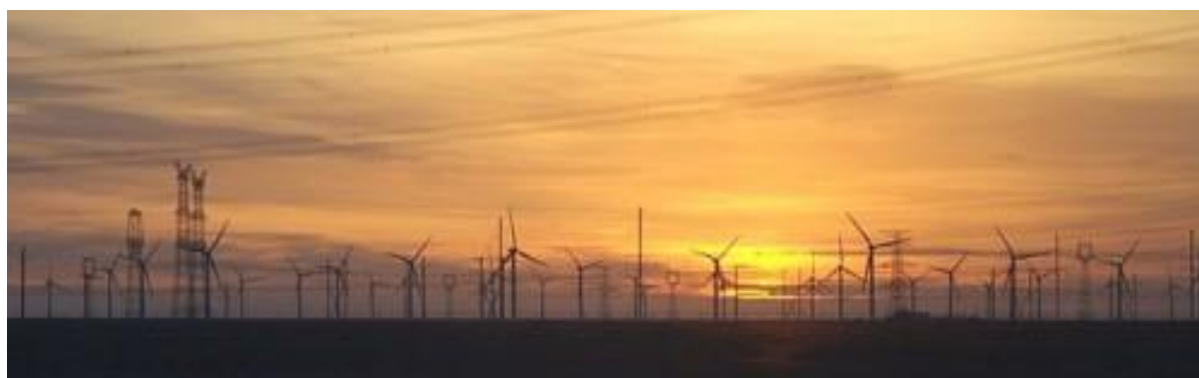
Slika 17. Gansu vjetropark u Kini, najveća kopnena vjetroelektrana na svijetu [17]
