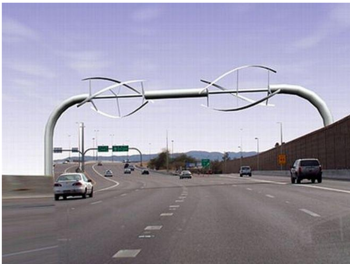
Slika 15. Horizontalna izvedba Darrieus-ove vjetroturbine [14]
