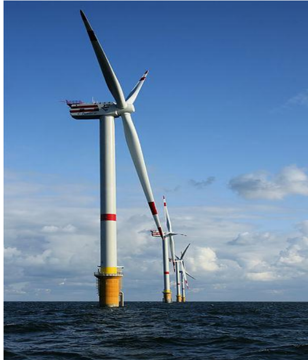
Slika 10. Rotor s tri lopatice [9]
