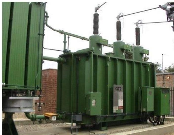
Slika 7. Primjer transformatora s pločastim zavjesnim elementima
