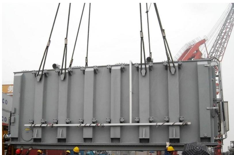
**Slika 10. Primjer dizanja velikog energetskog transformatora**
