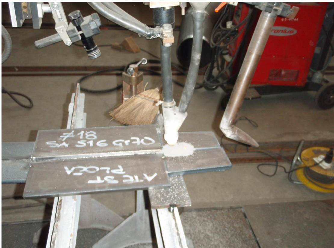
Slika 45. Uspostava električnog luka kod EPP zavarivanja [29]
