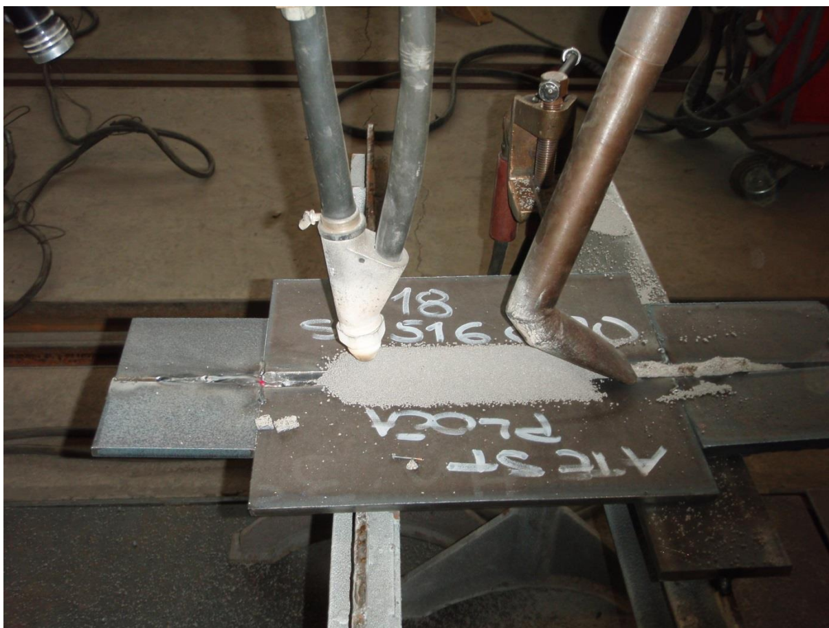
Slika 47. Prikaz EPP zavarivanja sučeljenog spoja iz osnovnog materijala SA516 Gr70 [29]
