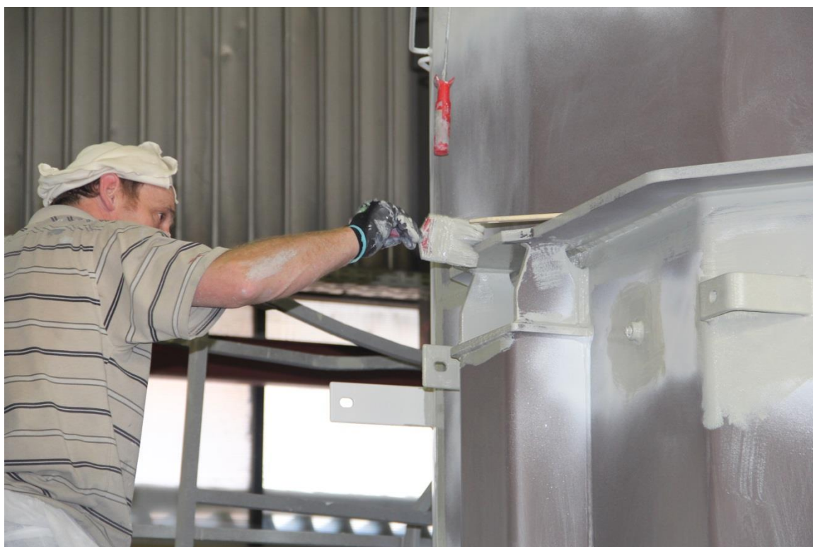
Slika 14. Nanošenje premaza kistom, Končar – Metalne konstrukcije d.d. [2]
