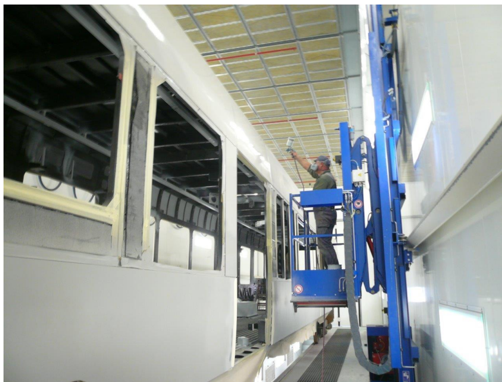
Slika 29. Aplikacija vodorazrjedivog epoksidnog premaza na vagon, TŽV Gredelj
