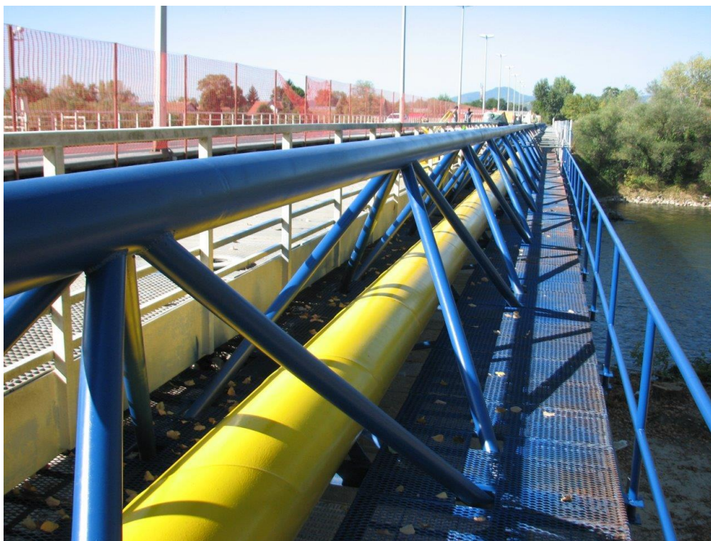
Slika 28. Primjena epoksidnog premaza na mostovima, Podsusedski most
