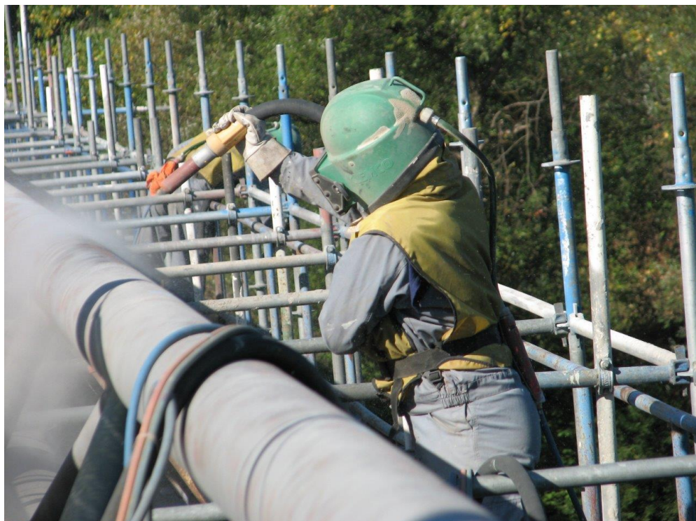
Slika 13. Prikaz pripreme površine postupkom pjeskarenja
