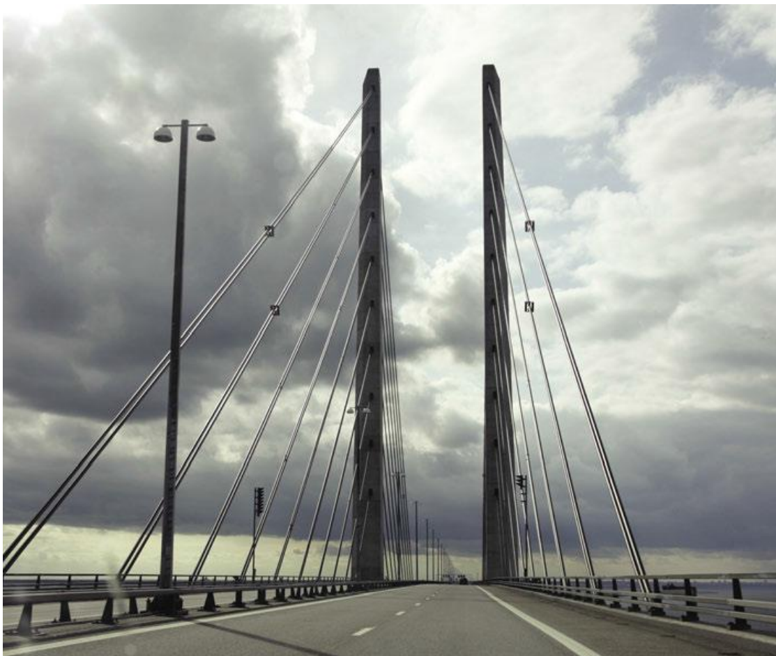
Slika 37. Most Øresund zaštićen temeljnim premazom s visokim udjelom cinka, čiji sustav je projektiran tako da nema potrebe za naknadnim održavanjem više od 100 godina [28]
