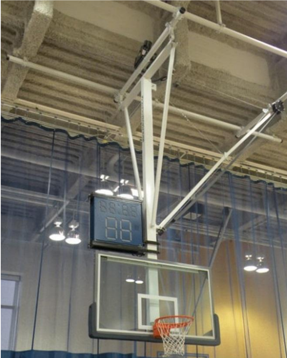
Slika 4. Konstrukcija s bočnim podizanjem i polugom za učvršćenje s bočne strane
