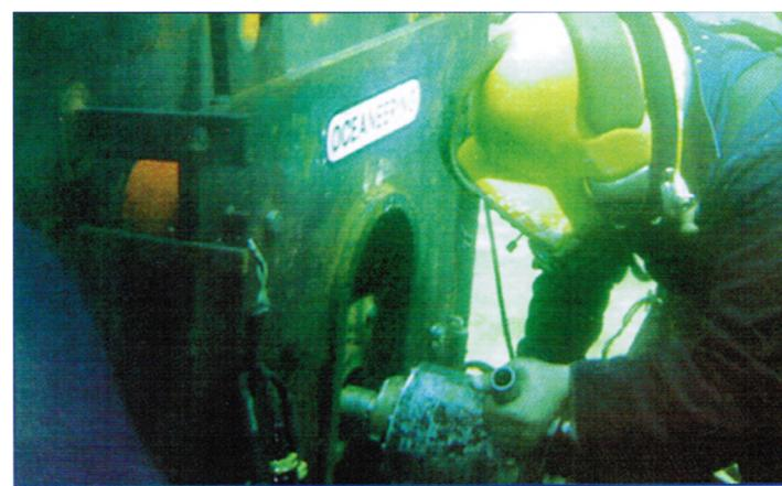
Slika 25. Podvodno zavarivanje trenjem [20]
