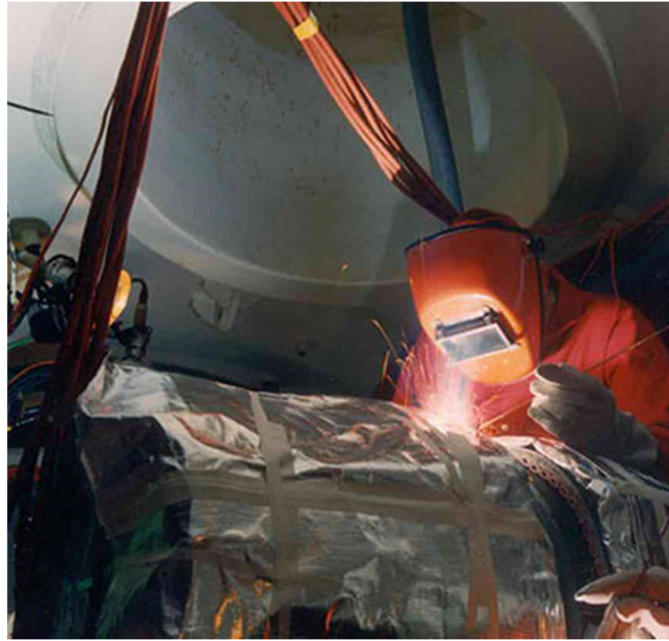
Slika 1. Zavarivanje u suhoj hiperbaričkoj komori [4]
