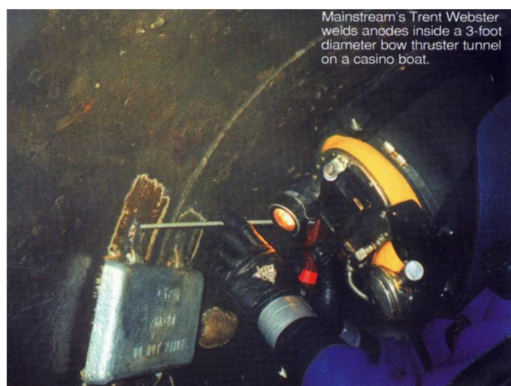
Slika 28. Izmjena cinkove anode [21]
