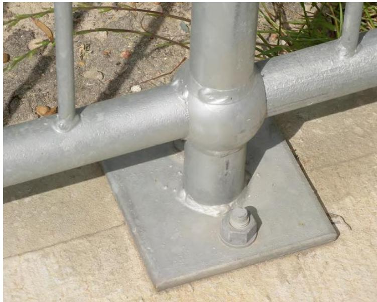
Slika 12. Primjer zavara na pocinčanoj ogradi [11]
