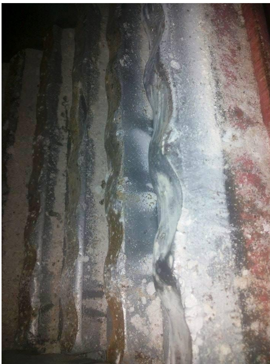
Slika 47. Tragovi trošenja na donjim udarnim oblogama u kućištu ispod rotora
