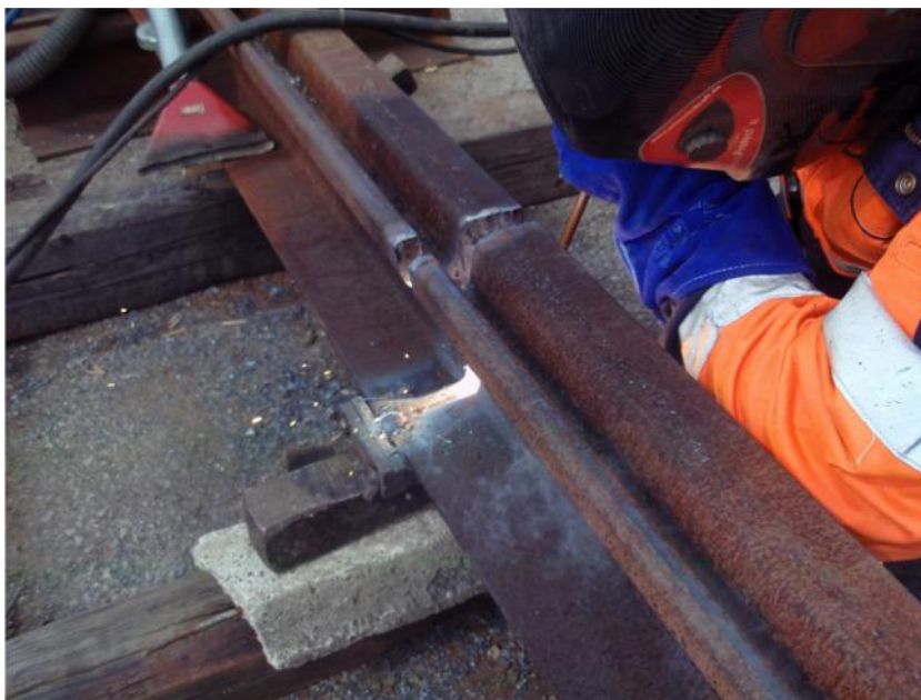
Slika 4.5. Zavarivanje nožice tra nice
