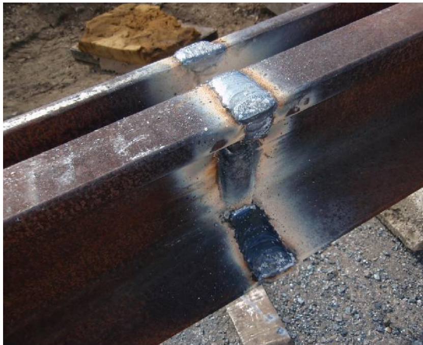
Slika 4.7. Konačni izgled zavara tračnice prije brušenja
