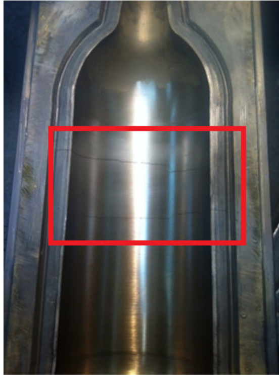
Slika 97. Pukotine kod brončanog kalupa - primjer 2
