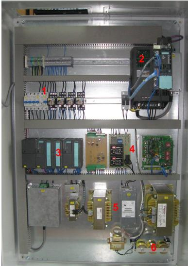
1 – kontaktori i automatski osigurači, 2 – pretvarač snage izmjeničnog motora, 3 – Programabilni logički kontroler (PLC) opremljen numeričkim (FPGA) kontrolerom, 4 – el. pločice sa sklopovljem za upravljanje jednofaznim izmjenjivačem, 5 – prigušnice i transformatori, 6 – kondenzatori za glađenje(niskopropusno filtranje) napona izmjenične mikromreže.
