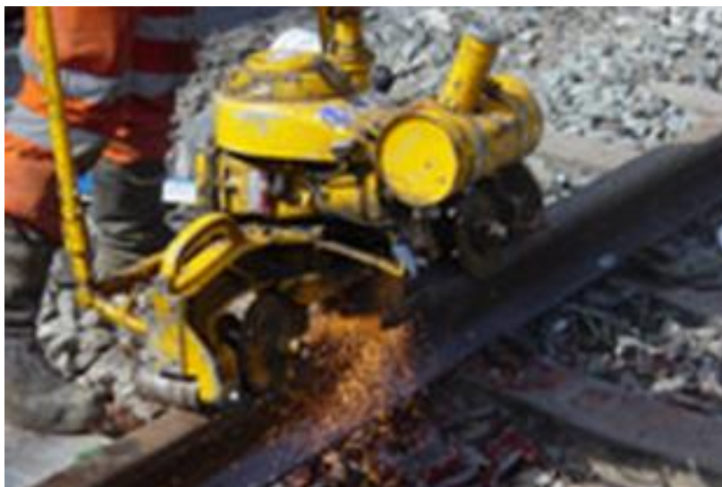
Slika 33 Završno brušenje tračnica [4]
