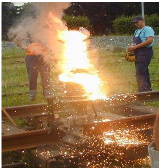
Slika 30 Aluminotremijska reakcija u tiglu [16]
