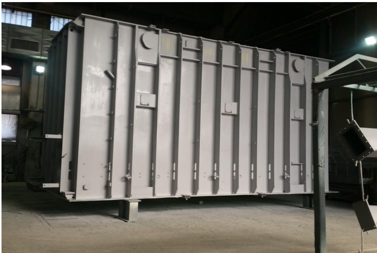
Slika 27. Sušenje transformatorskog kotla nakon nanesenog prvog premaza
