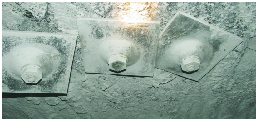
Slika 9. Prikaz ugrađenih sidra u okno rudnika
