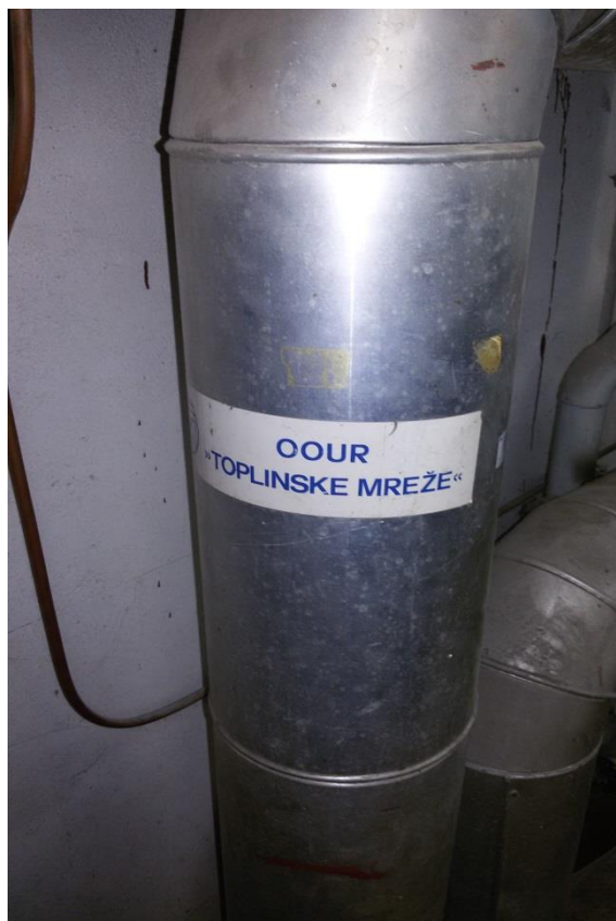
Slika 27. Glavni vod iz gradske toplinske mreže
