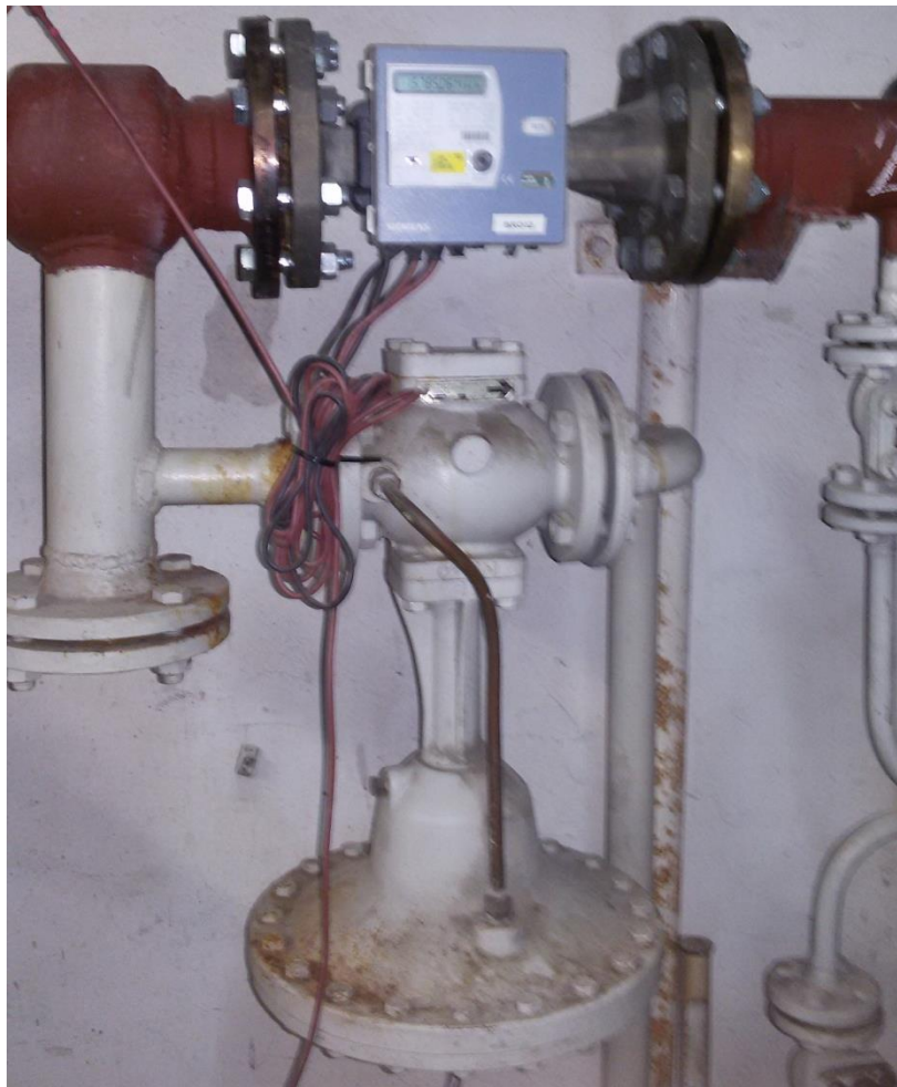
Slika 31. Sigurnosni ventil TS-Sjever FSB
