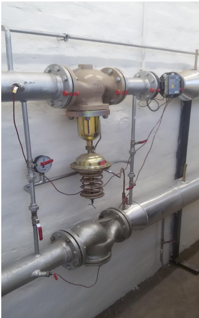
Slika 10. Sigurnosni ventil TS FSB Jug-Istok
