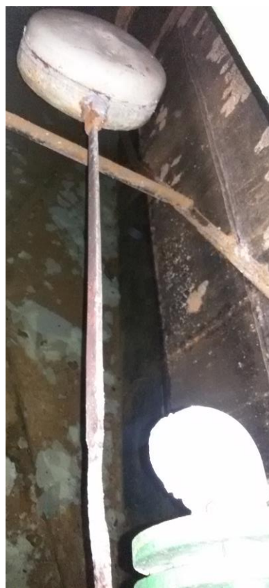
Slika 15. Plovak za regulaciju visine vode
