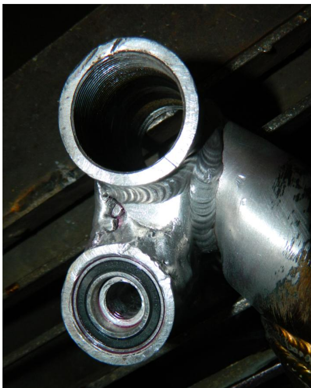
Slika 24. Zavar nakon što je vodom ispran penetrant
