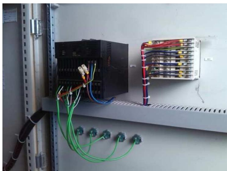
Slika 20. Prikaz spajanja termoelementa na registrator temperature
