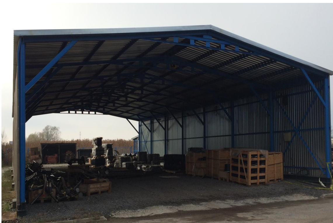
Slika 36 Natkriveno skladište poduzeća Monting d.o.o.
