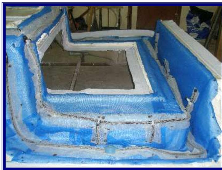
**Slika 4.21** Krug cjevovoda smole na krmenom dijelu palube
