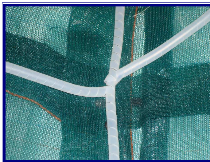
Slika 4.14 Postavljanje cjevovoda smole
