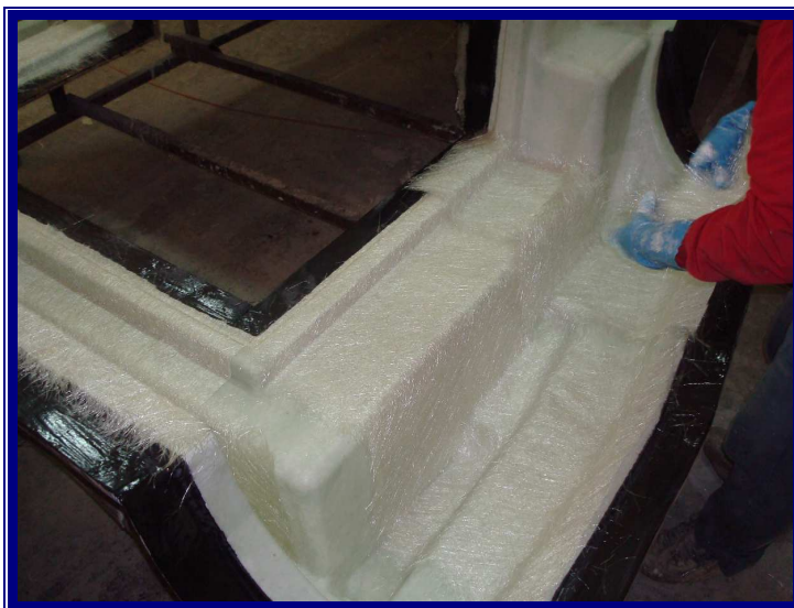
Slika 4.17 Postavljanje prvog sloja laminata na kalup palube
