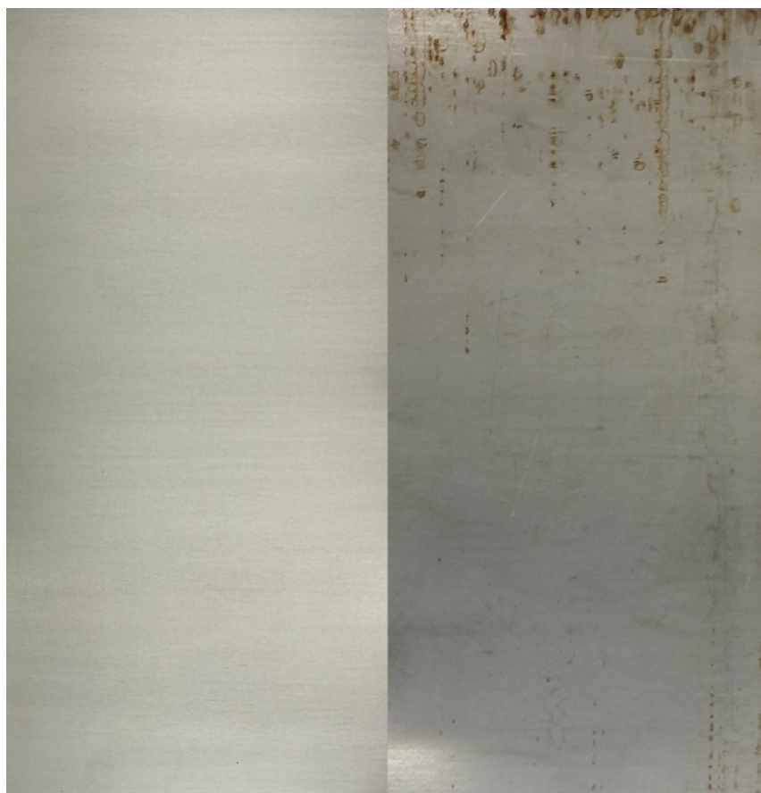
Slika 53. Prikaz površinske pripreme osnovnog materijala, lijevo-očišćeno, desno-neočišćeno
