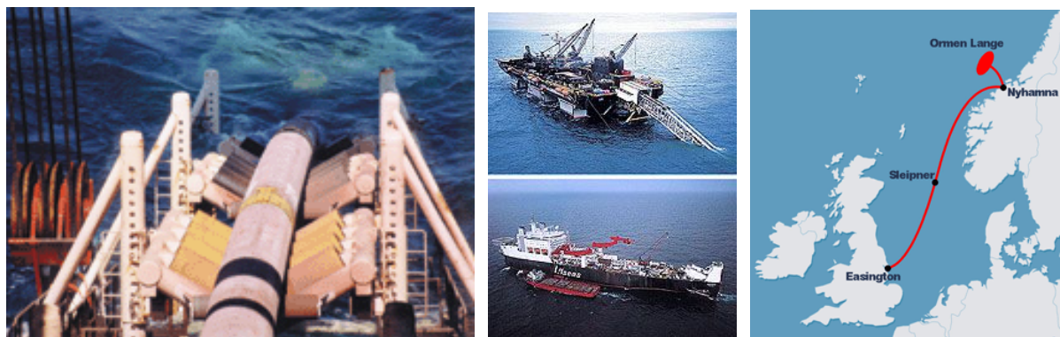
Slika 1.1 Polaganje cjevovoda između Aukre i Easingtona (Norveška - Ujedinjeno kraljevstvo) [2]
