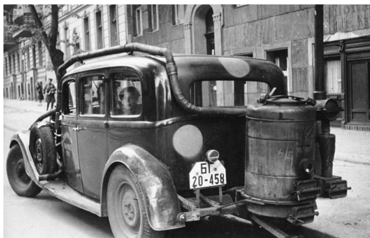
Slika 2. Generatorska jedinica smještena na zadnjem kraju automobila [13]
