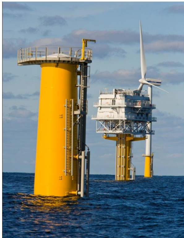
Slika 14. Čelični tornjevi vjetroturbina [16]
